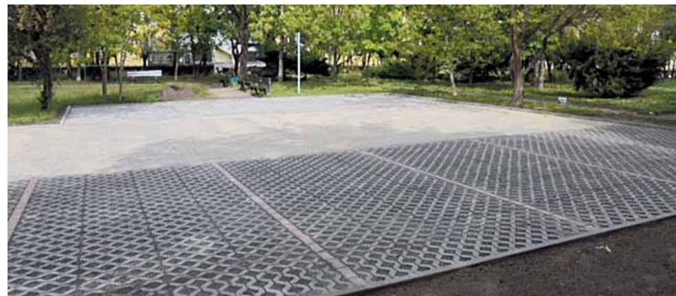
Nowy parking dla mieszkańców budynku przy Powstańców Śląskich zorganizowany w ramach rekompensaty za udostępnienie wykonawcy miejsca na zaplecze placu budowy
