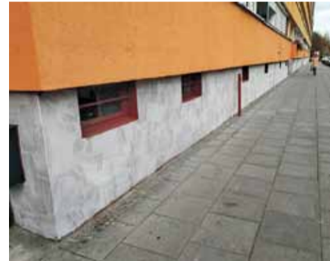
Remont na Drukarskiej
