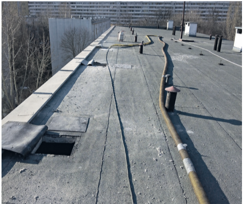
Docieplenie stropodachu przy ul. Drukarskiej 16-20a. Docieplano również budynki przy ul. Drukarskiej 26-30 oraz przy ul. Wielkiej 53-59 oraz przy ul. Drukarskiej 2-8.
