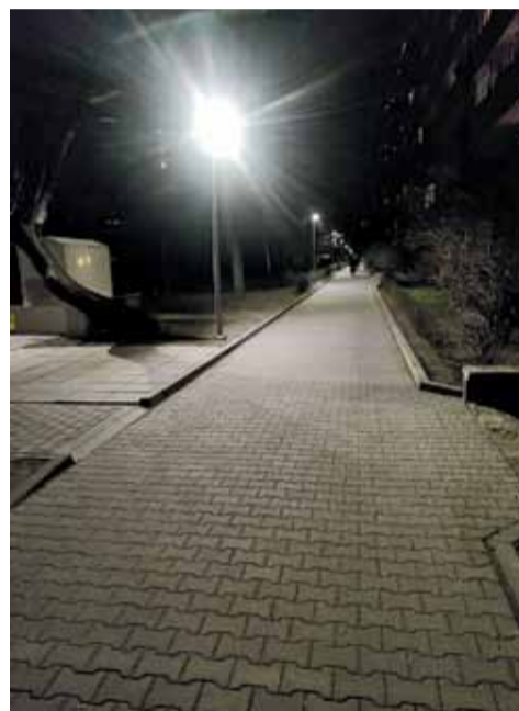
Montaż oświetlenia – Drukarska 31-47
