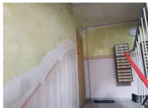
Drukarska 26-30 remont klatki schodowej – malowanie wraz z gładziami
