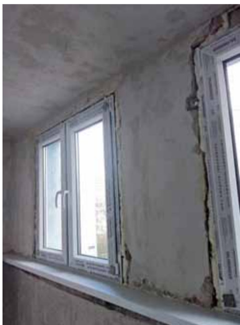
Wymiana okien wraz z parapetami – Drukarska 26-30
