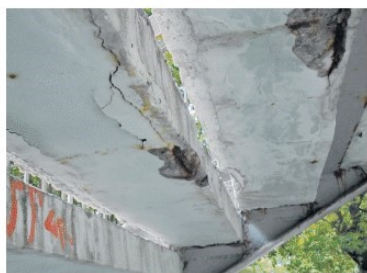
Stopnie schodowe przed remontem
